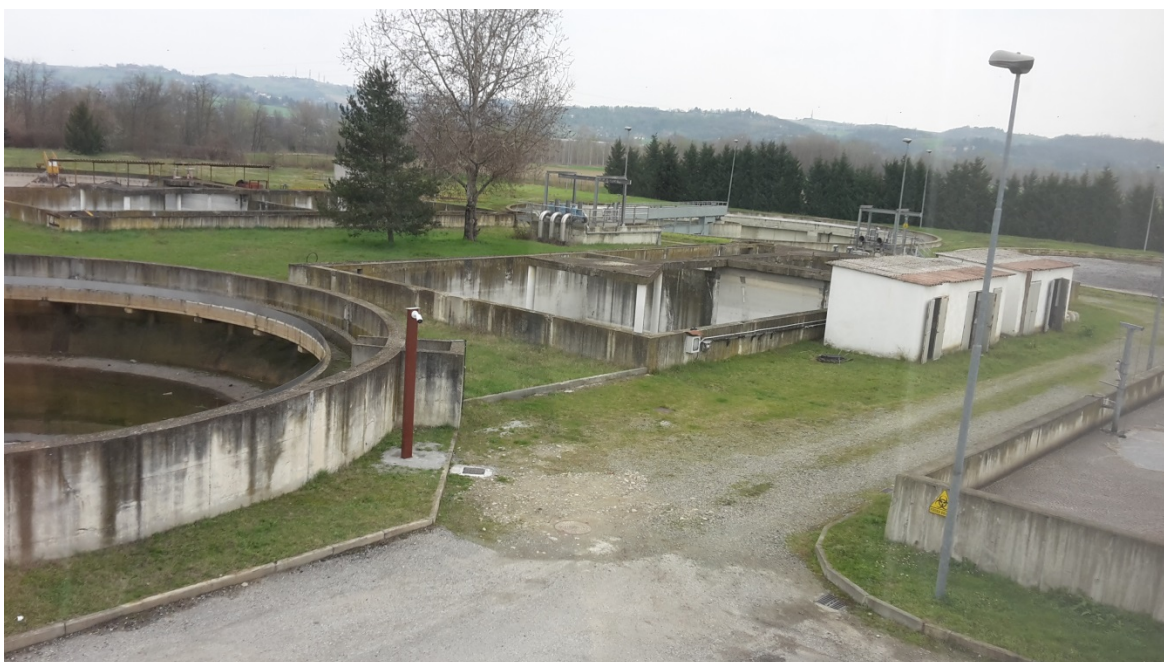
FIG. 14.2 - VISTA DI DECANTATORE PRIMARIO E VASCA BIOLOGICA
