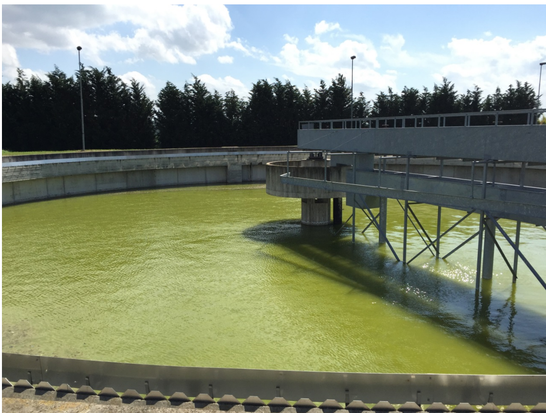
FIG. 14.7 - DECANTATORE FINALE
