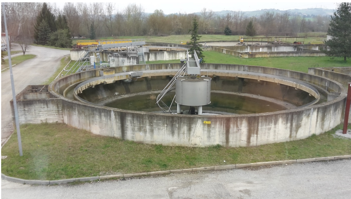
FIG. 14.3 - DECANTATORE PRIMARIO
